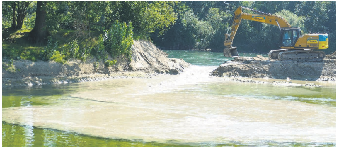
Schaufel für Schaufel öffnet der Bagger den Damm. Reusswasser, zusammen mit Sand und Humus, strömt in die Auen-Arme.
